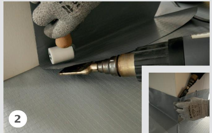
Die Außenecken können mit dem Quellschweißmittel QSM oder dem Heißluftföhn mit der Dachbahn verschweißt werden.
