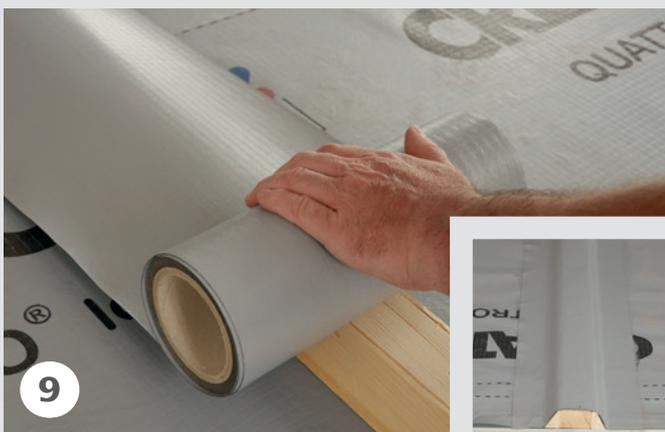
Ausrollen und auf Länge schneiden der Konterlattenkappstreifen KKS. In der Breite mittig auf die Konterlatte auflegen und mittels Quellschweißmittel QSM oder Heißluftföhn links und rechts mit einer Breite von mindestens 40 mm auf der Dachbahn dicht verschweißen.
