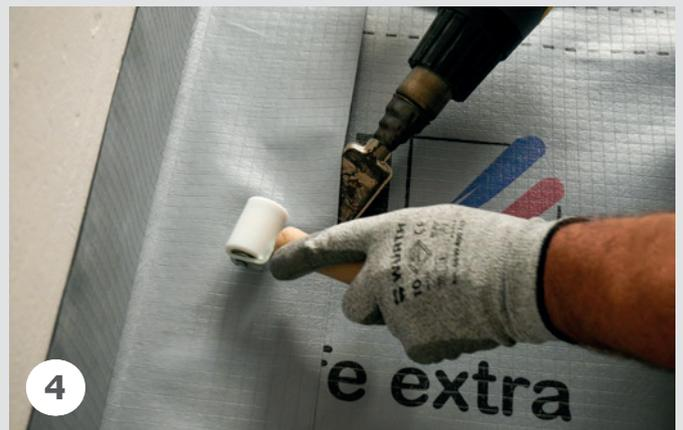
Die untere Hälfte mittels Quellschweißmittel QSM oder Heißluftföhn und Handrolle auf der Dachbahn verschweißen.
