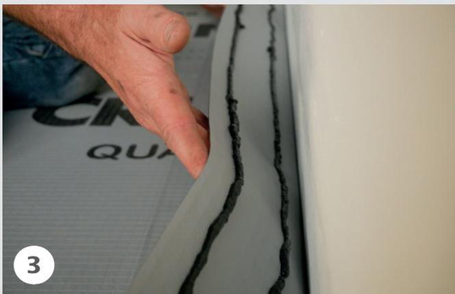
Anpressen der oberen Hälfte des Materialstreifens an der Wand. Eine durchgängige Verklebung muss gewährleistet werden.
