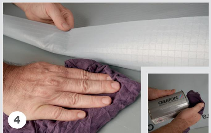
Die Vorab-Fixierung der Längsstöße mit der Hand fest andrücken und zusätzlich mit der Handrolle anpressen.
