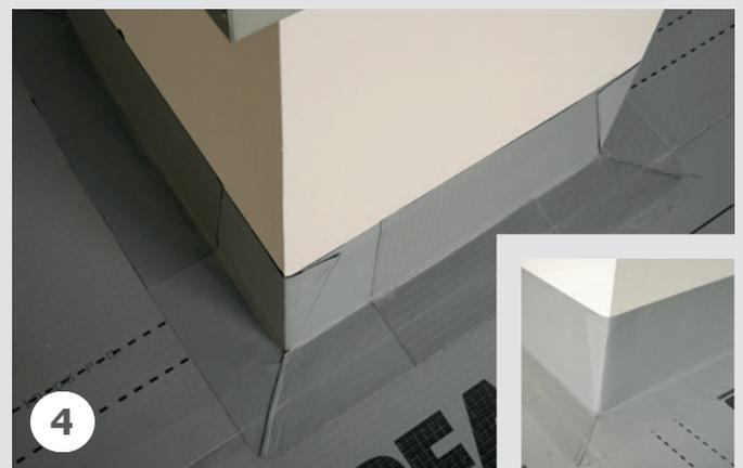
Die umgeschlagenen Ecken sollten im Verlauf der Wasserführung verschweißt werden. Die Bildung von Falten und Wassersäcken ist zu vermeiden.
