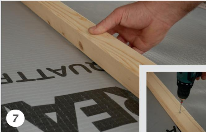
Die Konterlatten werden auf die Bahn aufgelegt und mit der Unterkonstruktion verbunden. Befestigung der Konterlatte gemäß Vorgaben ZVDH (für Österreich gilt entsprechend ÖNORM, für die Schweiz entsprechend SIA-Norm) und aktuellem „Stand der Technik“.
