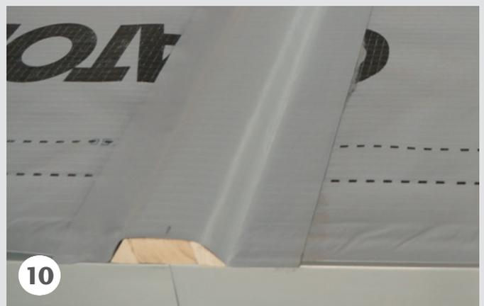
**Variante 1:** Die Konterlatte wird bis zur Traufe geführt und an den Stirnseiten zur Entlüftung offen gelassen.
