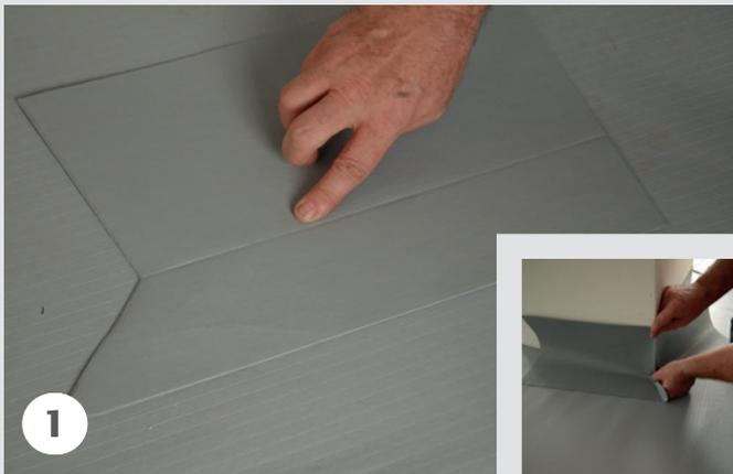
Auslegen der vorgefertigten QUATTRO-Außenecke. Die vorgestanzte Linie gibt die jeweiligen Überlappungsbereiche vor. Die Breite kann entsprechend der Durchdringung angepasst und zugeschnitten werden.
