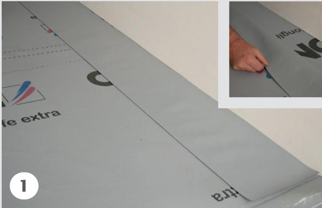
Konterlattenkappstreifen KKS oder je nach Material- und Überlappungsbedarf Abschnitte der Dachbahn ausrollen und auf Länge zuschneiden. Die Breite des Materialstreifens mittig falten und andrücken, um einen leichten Knick für die saubere Anpassung zu erzielen.
