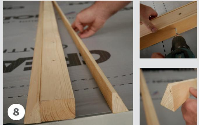
Dreikantleisten werden vorbereitet, links und rechts an der Konterlatte positioniert und verschraubt. Diese Trapezförmige Geometrie ermöglicht ein ungehindertes Abfließen von Feuchtigkeit und Nässe. Am Ortgang die Leisten nur einseitig zum Dachinneren anbringen.
