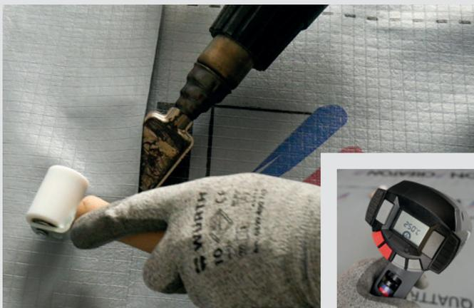
**Variante 2:** Längs- und Querstöße werden mittels Heißluftföhn und Handrolle durchgängig verschweißt. Der Föhn wird auf ca. 240 - 250 °C aufgeheizt und in einem geeigneten Anstellwinkel in den Überlappungsbereich geschoben. Mit der Handrolle wird die Überlappung fest angepresst. Eine Nahtdichtheitsprüfung sollte vorgenommen werden. Fehlerhafte Stellen können nachträglich ausgebessert werden.
